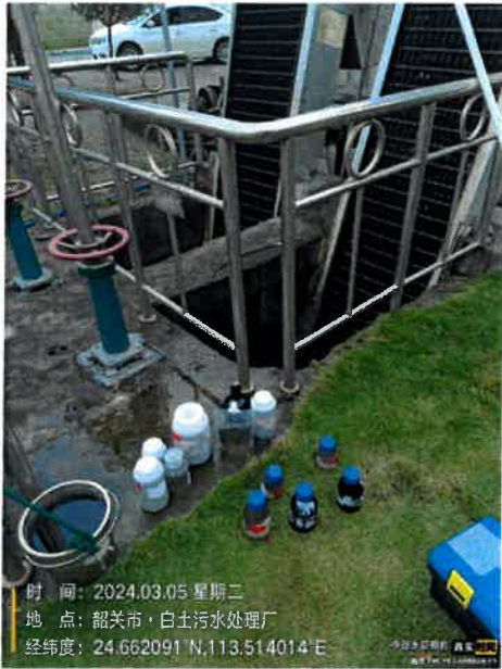
污水厂进水口
