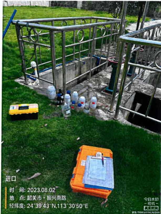
污水厂进水口
