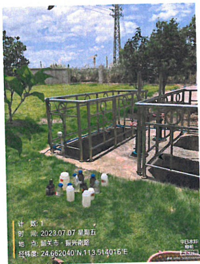
污水厂进水口
