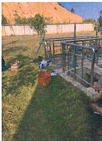
污水厂进水口
