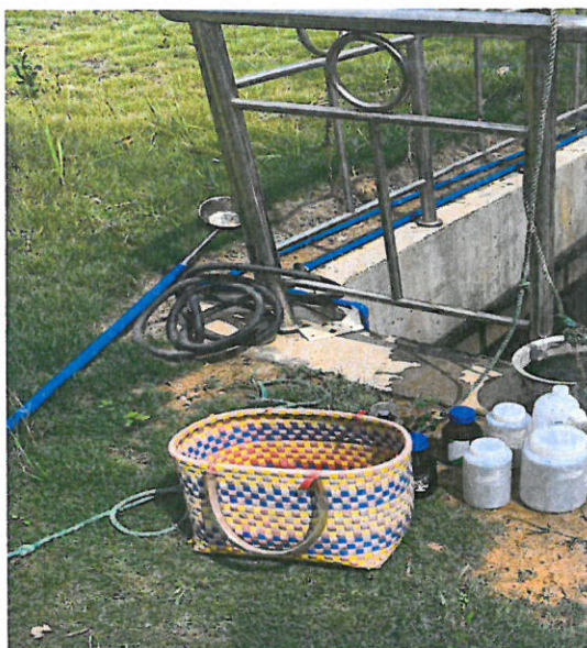
污水厂进水口
