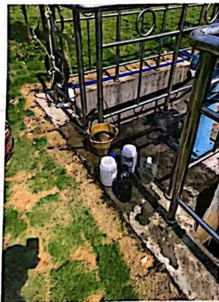
污水厂进水口
