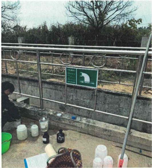
污水厂排水口（DW001）
