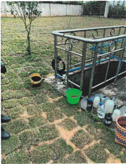
污水厂进水口
