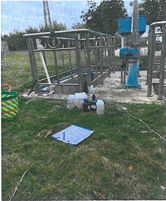
污水厂进水口
